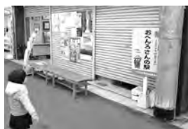
▲第6区間休憩所点検(坂出市商店街)
